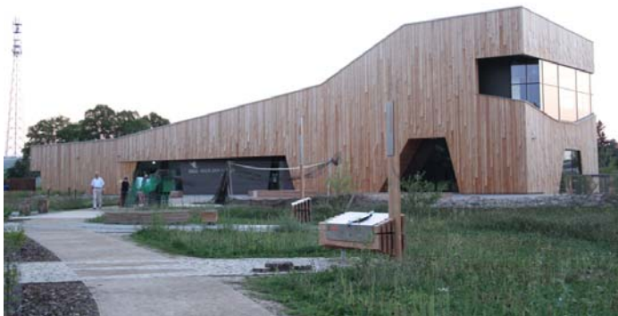
Das „Haus der Flüsse“ in Havelberg.
